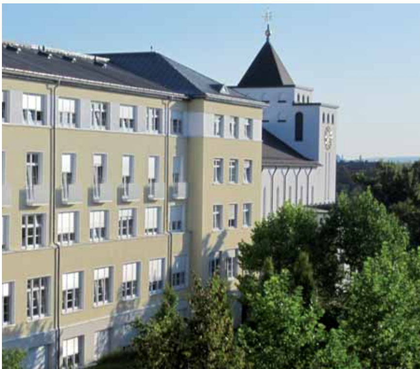
Die Kirche St. Pius (hinten) sowie der ehemalige Männerbau des Krankenhauses mit Konvent, den noch Frater Eustachius Kugler errichten ließ
