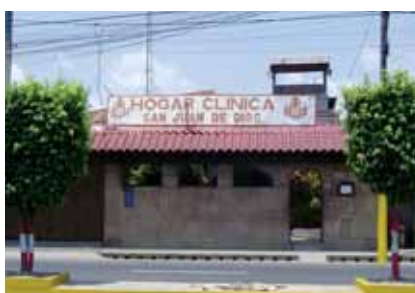
Eingangsbereich der bestehenden Klinik
